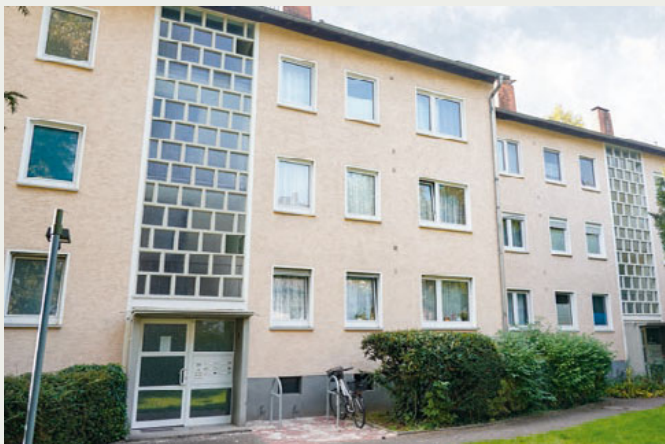
Das Gebäude aus den 1960er-Jahren muss energetisch saniert werden.
