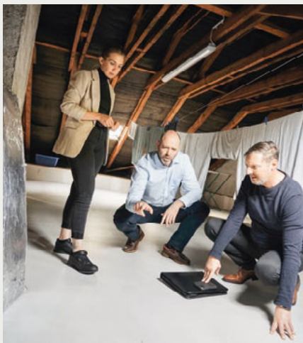
Effizient: Dämmung der Dachbodendecke.
